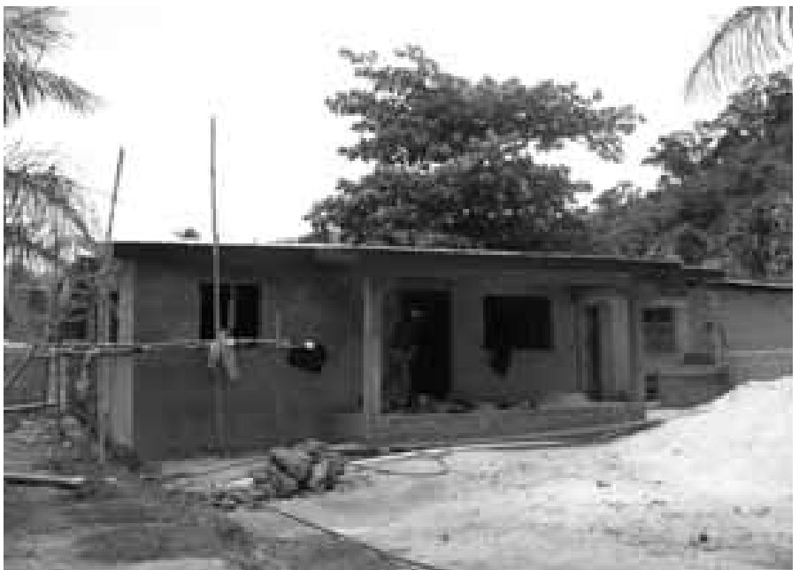
La nuova casa di Mabinti, da ultimare
