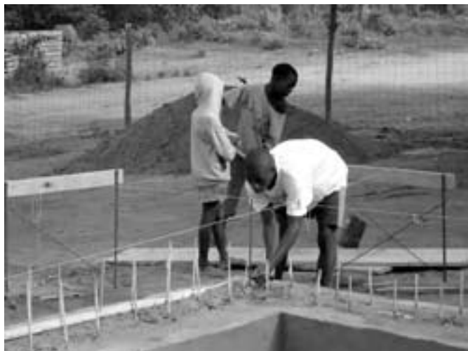
Al lavoro con le fondazioni
