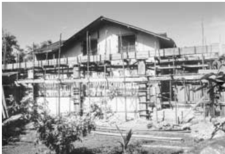
La scuola in ristrutturazione.
