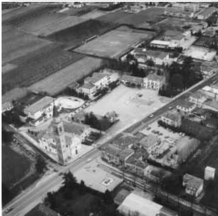
Veduta aerea del Centro di S. Giorgio in Bosco
