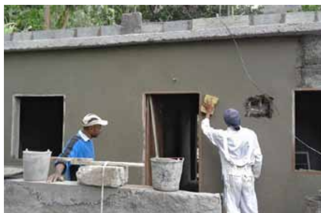
Lavori di ristrutturazione
