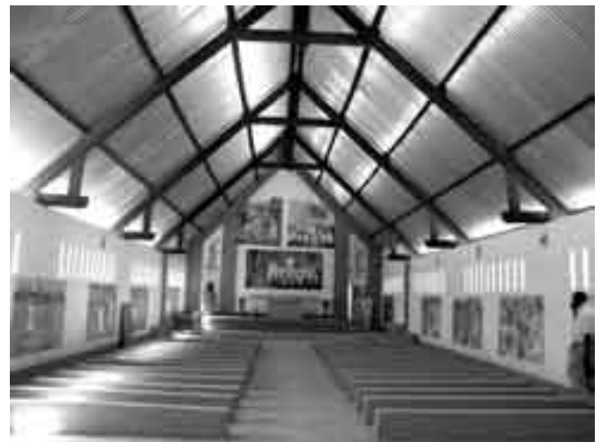
L'interno della chiesa di Baro
