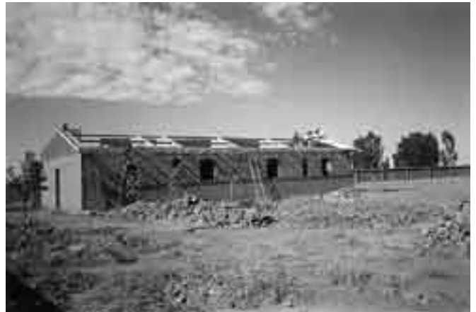
La scuola in costruzione
