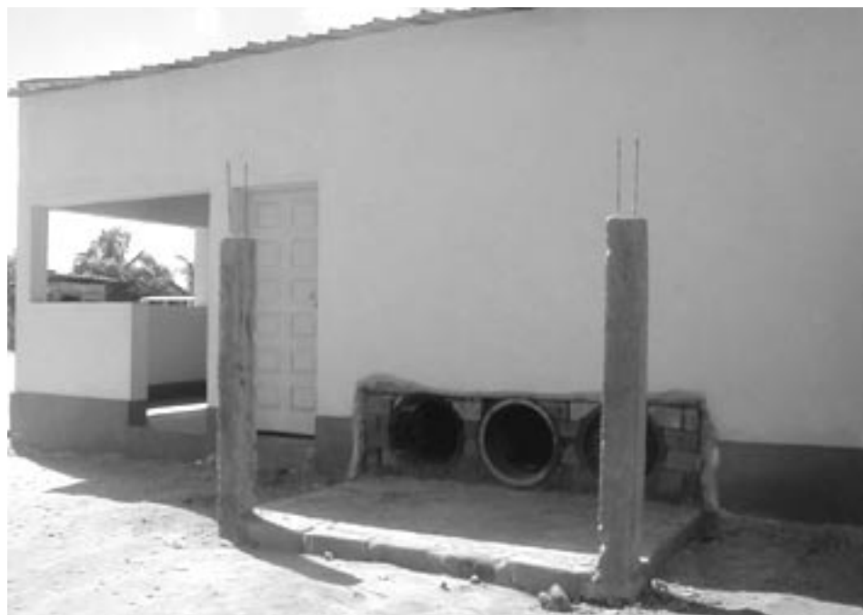
Ecco la foto di una delle cucine in costruzione
