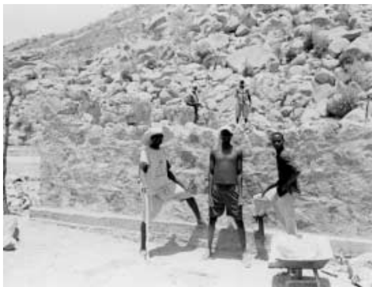
Inizia la costruzione del magazzino
